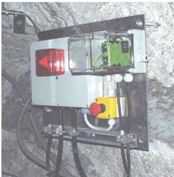
Fig.: Luce flash compatta utilizzata per un'apparecchiatura di sicurezza in una galleria. Il range di tensione di alimentazione pari a 70–264 V AC e 73–140 V DC supporta sia l'alimentazione con tensione di rete che quella della batteria d'emergenza
