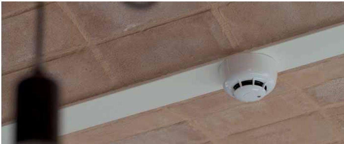
Air2-FD100 è un rivelatore di fumo che permette di aggiungere alla centrale antintrusione Inim la possibilità di dare indicazioni rispetto alla presenza di fumo nell'ambiente. Tale dispositivo è il perfetto complemento di ogni impianto domestico.
